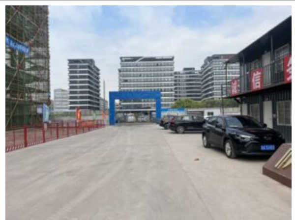
施工出入口现状
