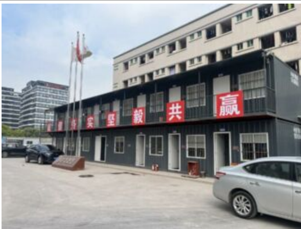
施工营地现状
