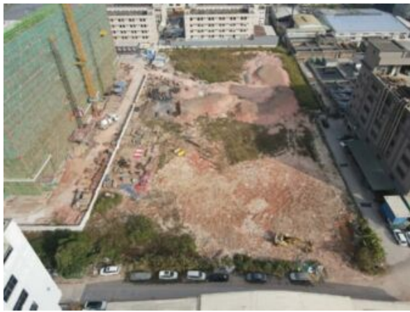
施工扰动区航拍现状
