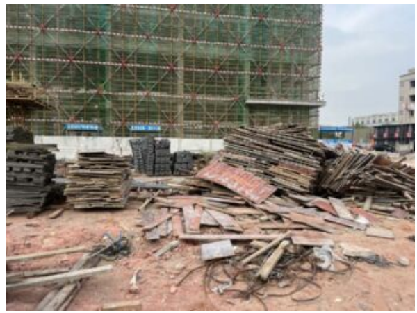
施工扰动区现状
