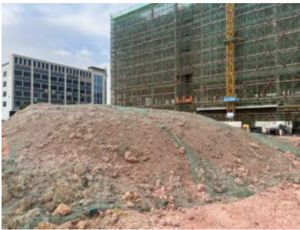
施工扰动区现状
