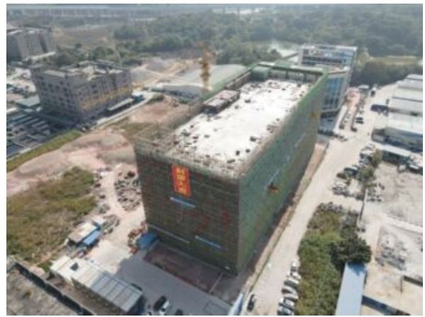
主体工程区航拍现状
